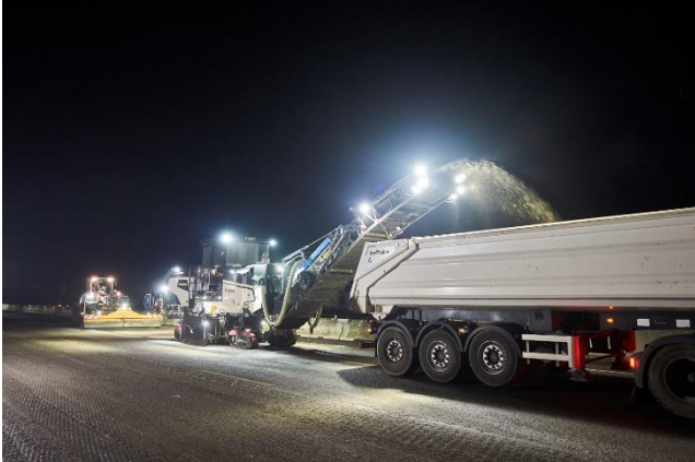
Rabotage de l'ancienne chaussée
