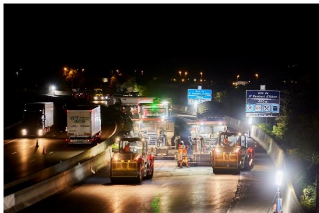
Application des nouveaux enrobés
