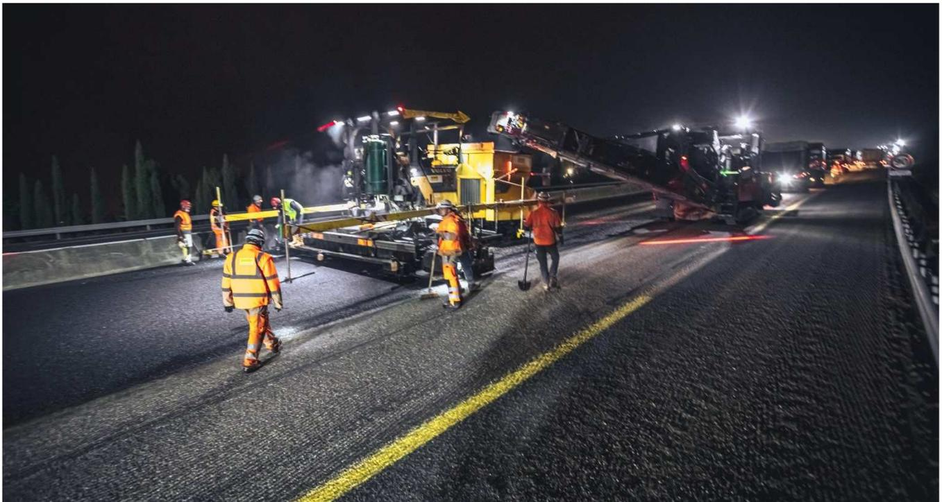
Engagé par VINCI Autoroutes depuis l'automne 2021, ce chantier de rénovation des chaussées de l'autoroute A7 concerne 24 km de chaussées (12 km par sens) entre les échangeurs d'Avignon-Le Pontet (n°23) et d'Avignon-Châteaurenard (n°24). Pour préserver des conditions de circulation optimales pour les conducteurs, les travaux sont réalisés exclusivement de nuit, du lundi soir au vendredi matin. Ils nécessitent la fermeture partielle de l'échangeur d'Avignon-Le Pontet (n°23) durant 3 nuits.
